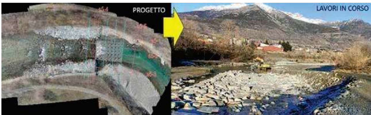
Lavori di ripristino delle continuità fluviale in Dora Baltea (Progetto LIFE GRAYMARBLE)
